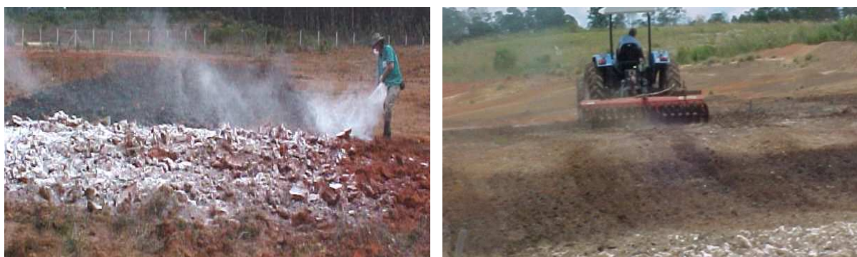
FIGURA 04: APLICAÇÃO MANUAL DE CALCÁRIO EM ÁREA DEGRADADA E POSTERIOR INCORPORAÇÃO EM JANEIRO/2003. AEROPORTO INTERN. DE CURITIBA.
