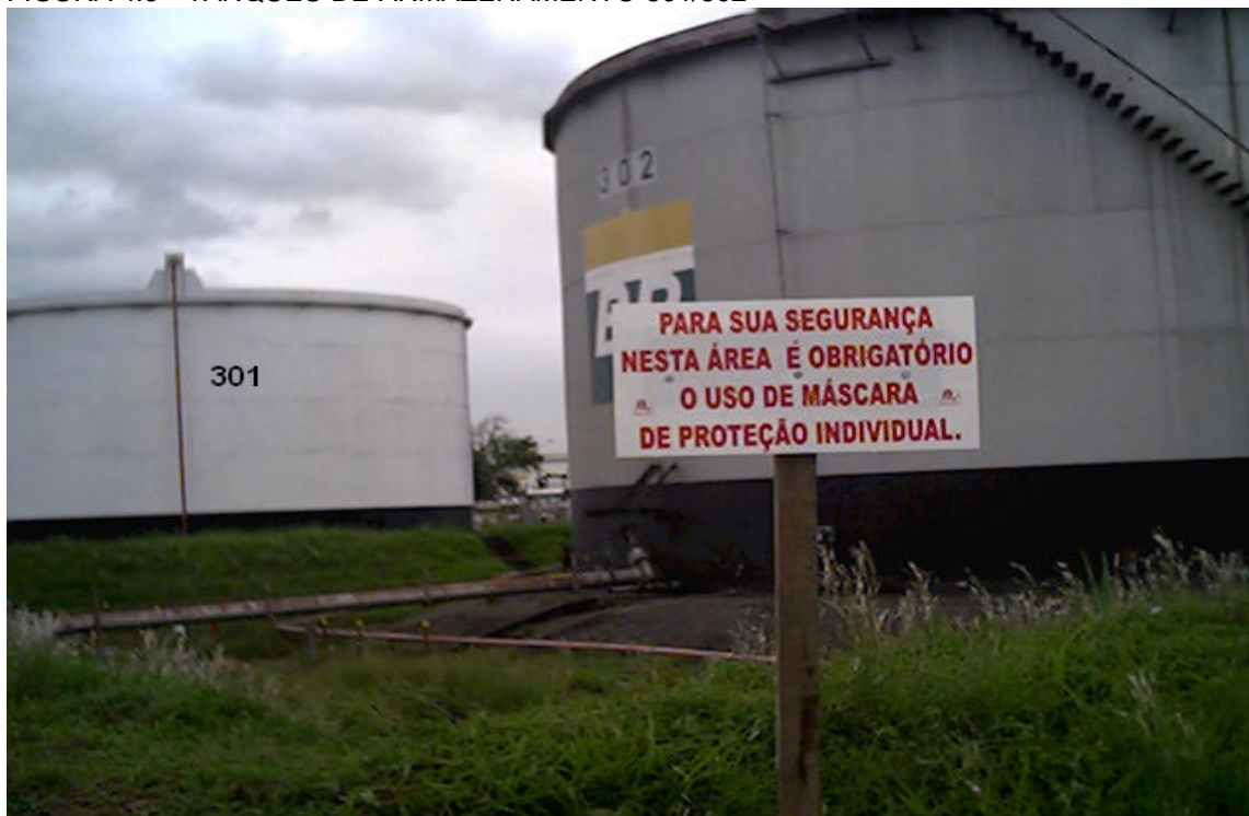
FIGURA 4.6 - TANQUES DE ARMAZENAMENTO 301/302
