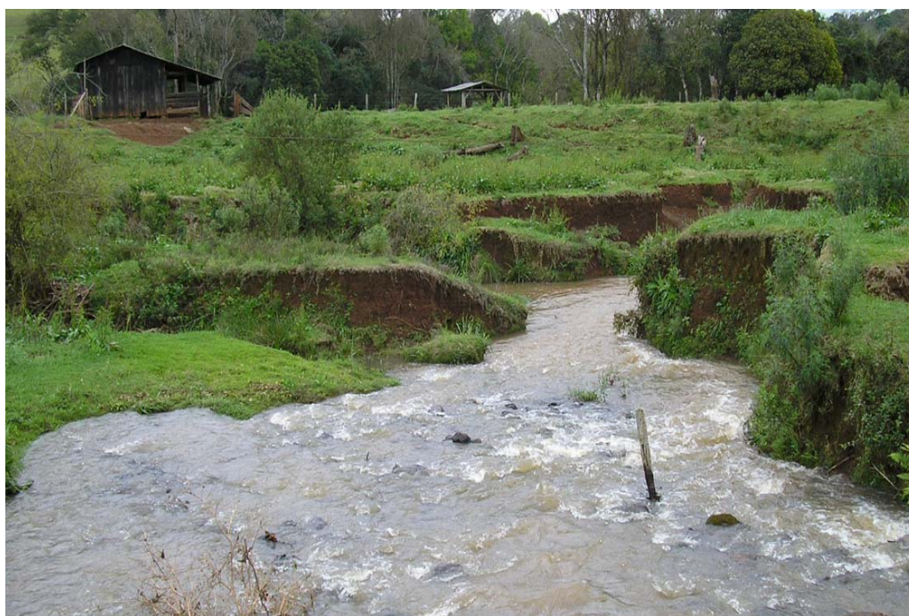
FIGURA 07 – SITUAÇÃO DAS MARGENS A MONTANTE DO PONTO DE COLETA 2
