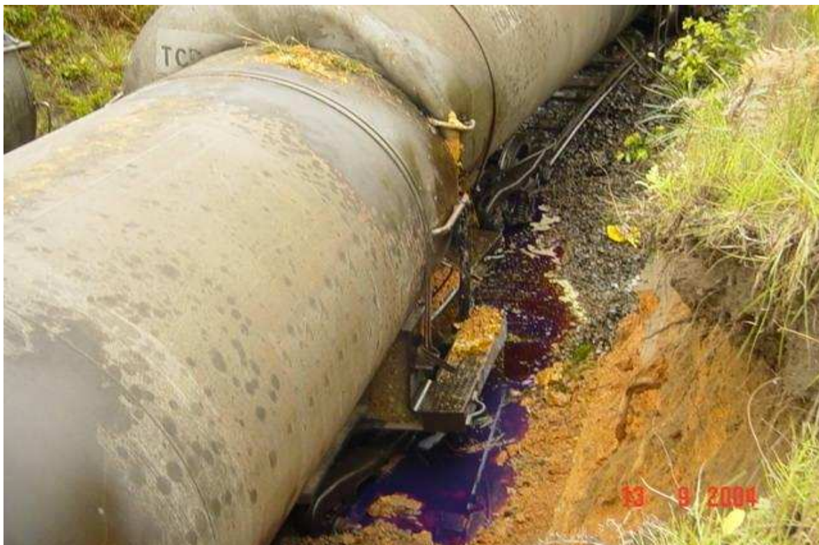
Figura 02: "Vagões Tanque Rasgados Culminando no Vazamento de óleo Diesel"
